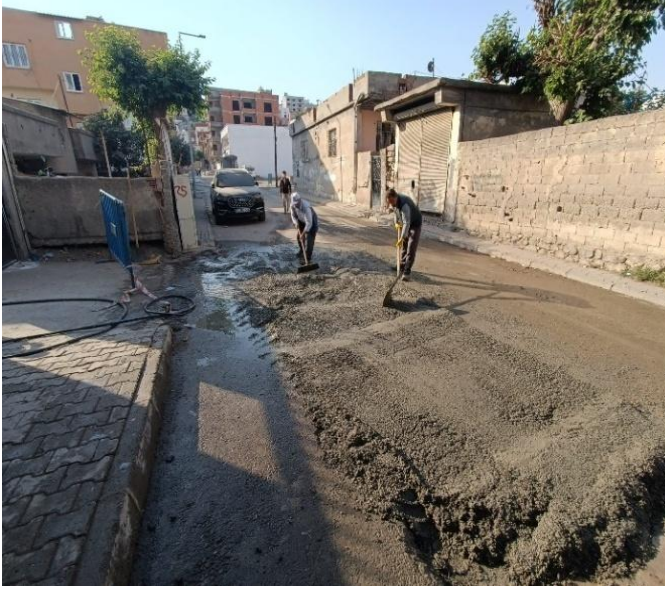
3-Hazır Beton Yama Çalışması: 745 m 2
