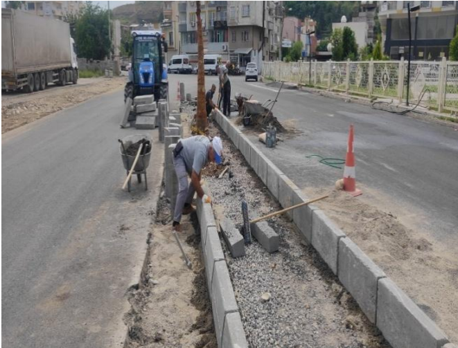
4-Orta Refüj Bordür Taşı Döşemesi Çalışması
