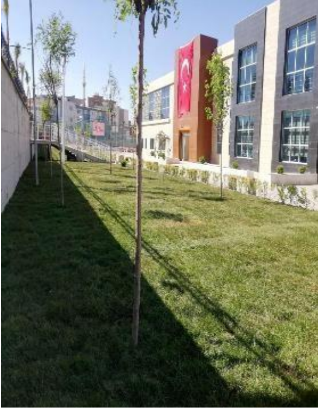
Kale Mahallesi Çevik Sokak Duvar Yapımı
