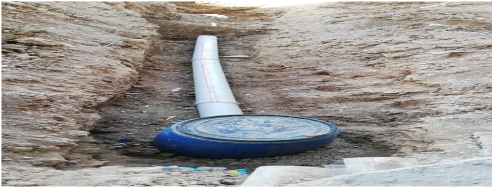
Yeni Kanalizasyon Abone Bağlantı Çalışması
