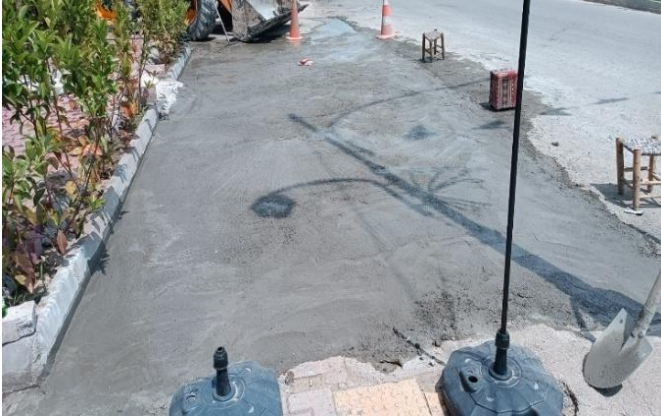
3-Hazır Beton Yama Çalışması: 745 m 2
